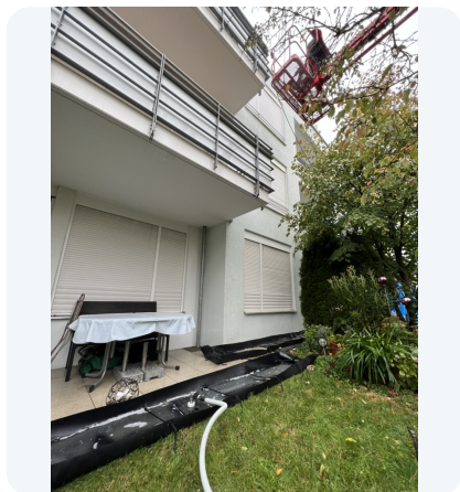
Schmutzwasseraufnahme mit Auffangrinnen und Schlauch.
