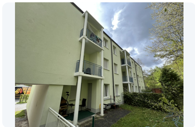
Wohnanlage nach der Fassadenreinigung.
