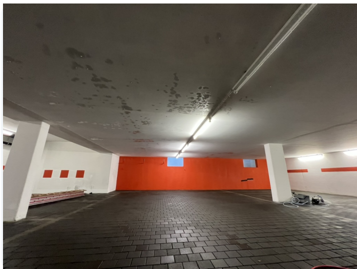
Tiefgaragenbereich mit angeschlossener Reinigungstechnik - eigene Arbeitsaufnahme.
