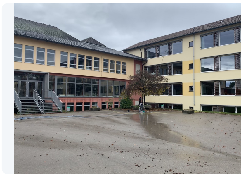
Wasserführende Teleskoptechnik im Innenhof.
